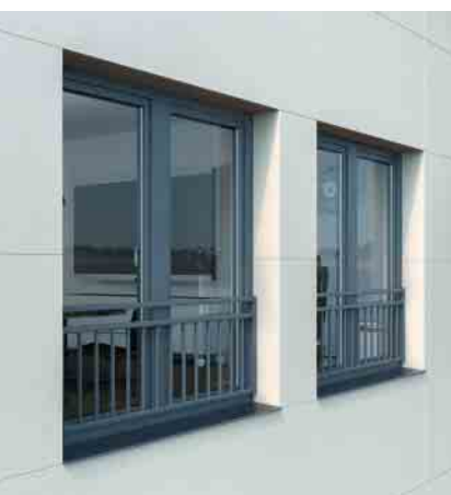
Die vertikale Aluminium-Stangenabsturzsicherung verschmilzt dank der Beschichtungsoption Ton-in-Ton zu einer optischen Einheit
